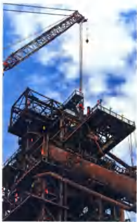
★ 2016年8月，包头钢铁集团炼铁厂拆除高炉淘汰落后产能
